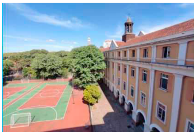
Na foto, o prédio e pátio da Fundação O Pão dos Pobres de Santo Antônio
