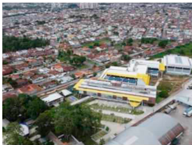
Na Fotografia o novo colégio La Salle de Ananindeua / PA
